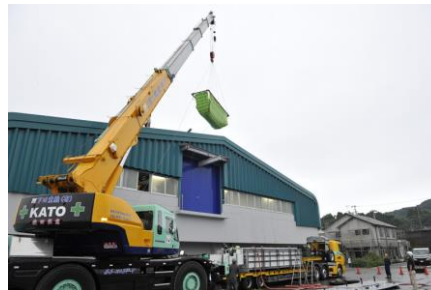
クレーンを用い海水から出さずに移動
