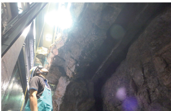
図5. 水抜き作業後、底からの様子
