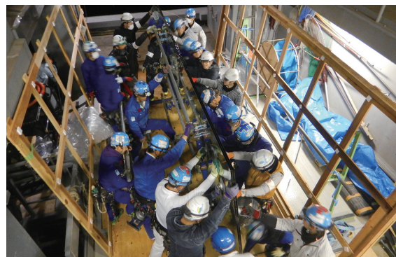
図14. 観覧通路を通過してガラスを運ぶ様子
